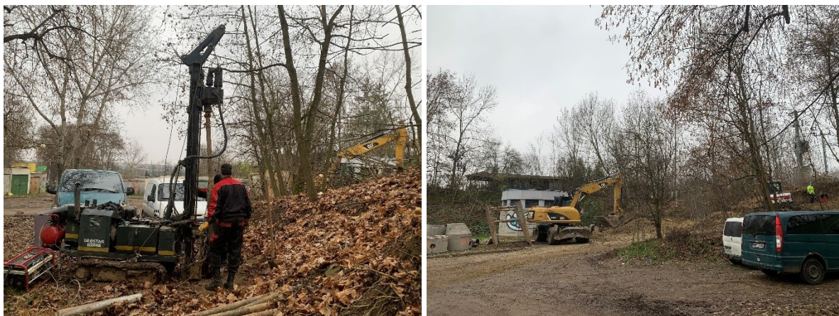
Obrázek 2: Výběr z fotodokumentace z realizace vrtných a kopných prací (GEOSTAR spol. s r.o.)
