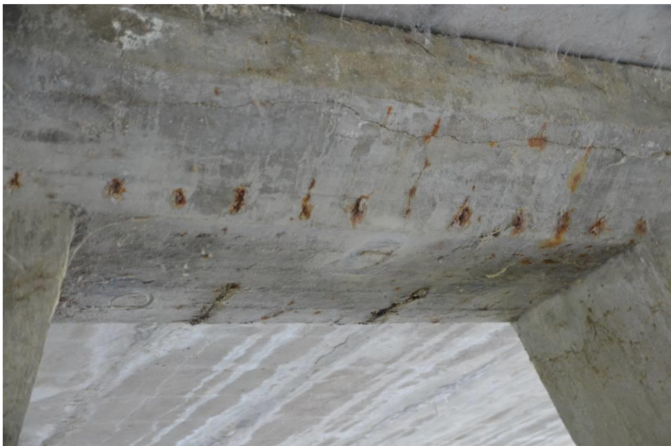
Obr.F45-30 Detail přední strany a podhledu UP druhé podpěry nad čtvrtým až pátým sloupem. Pohled ve směru staničení, po vodě a vzhůru,
