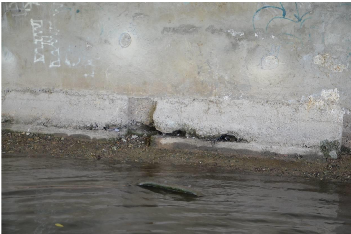
Obr.F45-159 Podpěra 4., levobřežní, žabovřeská opěra. Pohled diagonálně proti vodě a ve směru staničení,
