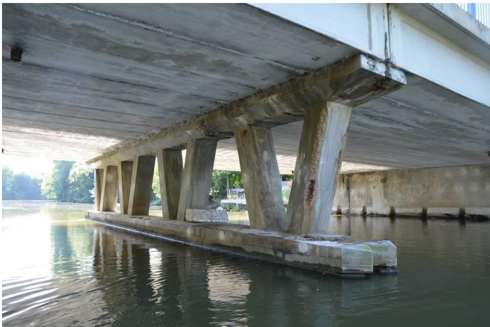
Obr.F45-140 Zadní strana a čelo návodního konce druhé podpěry. Pohled po vodě a proti směru staničení,
