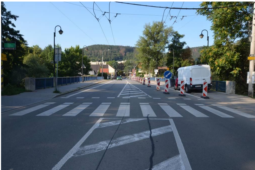
Obr.F45-02 Průhled osou mostu. Pohled proti směru staničení od Žabovřesk k Jundrovu,
