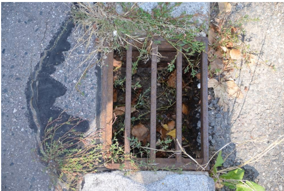
Obr.F45-198 Příklad mostního odvodňovače v levostranném obrubníku. Pohled ve směru staničení a dolů,
