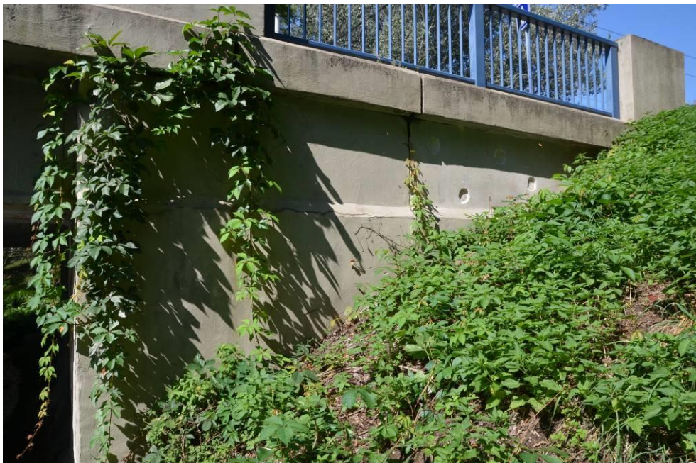
Obr.F45-169 Pravé, povodní křídlo 4. podpěry, žabovřeské opěry. Pohled zprava doleva (proti vodě) a ve směru staničení,
