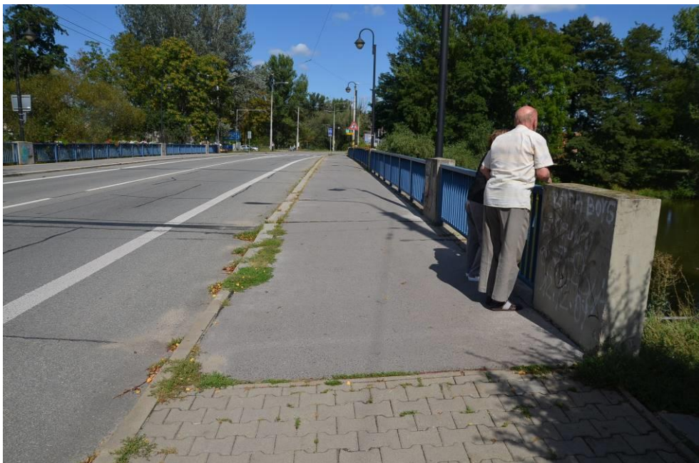
Obr.F45-191 Pravý, povodní okraj mostního svršku. Pohled od 1. podpěry ve směru staničení k Žabovřeskám,
