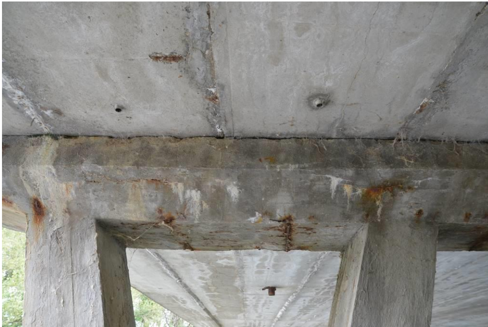
Obr.F45-26 Detail přední strany a podhledu UP druhé podpěry nad prvními dvěma sloupy. Pohled ve směru staničení a vzhůru, viz též obr. F45-142,
