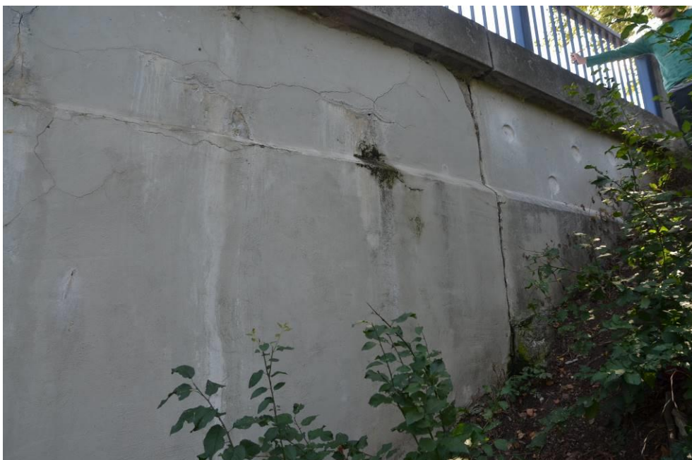
Obr.F45-162 Levé, návodní křídlo 1. podpěry, jundrovské opěry. Pohled zleva doprava (po vodě) a proti směru staničení,
