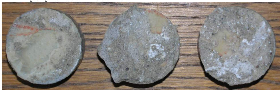
Obr.F45-614 Zkušební terče číslo 1, 6, 80 (zkušební místo 14) po provedení odtrhu.
