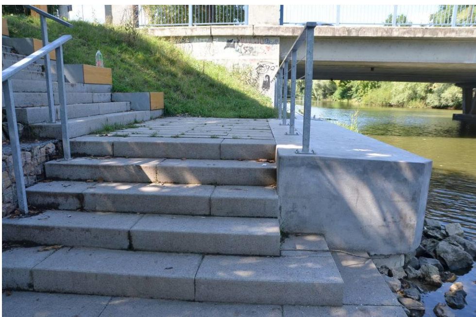
Obr.F45-165 Nábřežní zeď s upraveným přístupem do koryta řeky nava- zující na pravé křídlo 1. podpěry, pravobřežní, Jundrov- ské opěry. Pohled diagonálně proti vodě,
