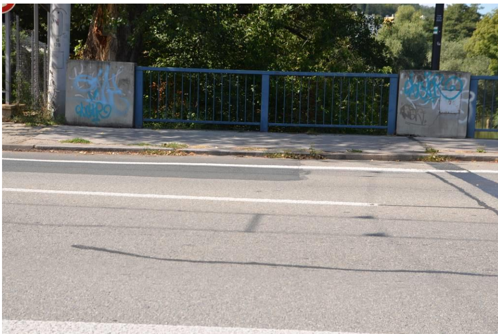
Obr.F45-194 Mostní svršek na začátku mostu. Pohled z pravostranného chodníku proti vodě,
