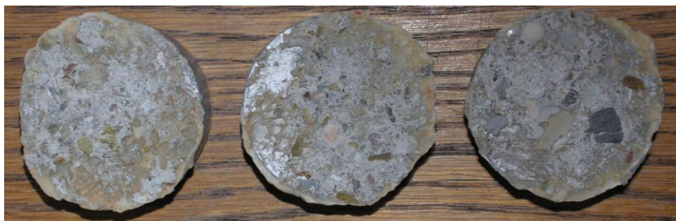
Obr.F45-608 Zkušební terče číslo 52, 59, 118 (zkušební místo 8) po provedení odtrhu.
