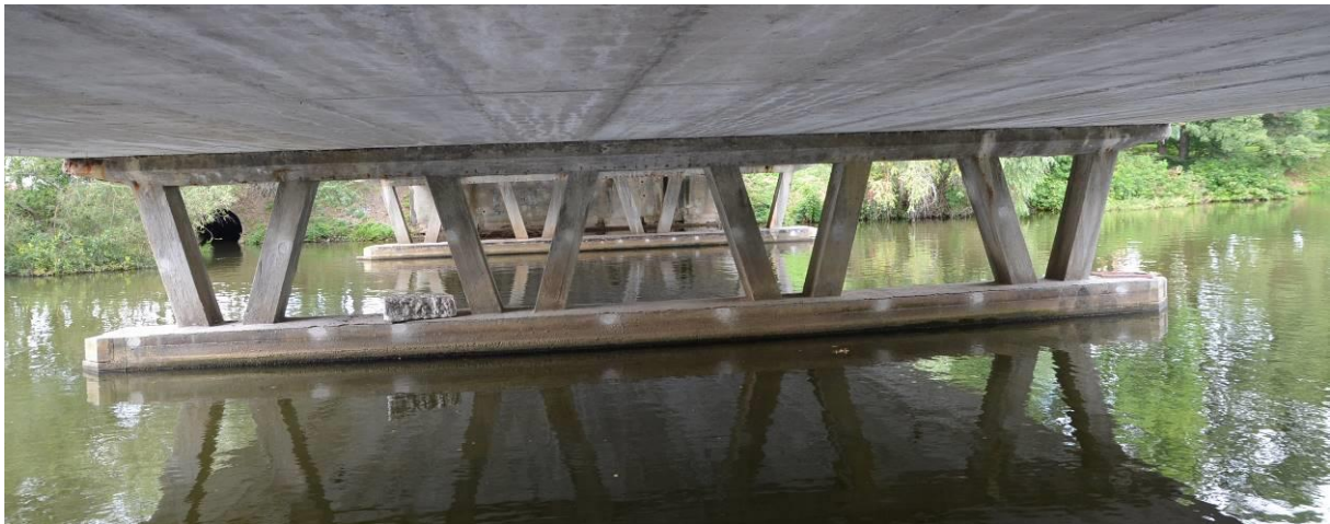
Obr.F45-09 Přední strana druhé podpěry. Pohled ve směru staničení,
