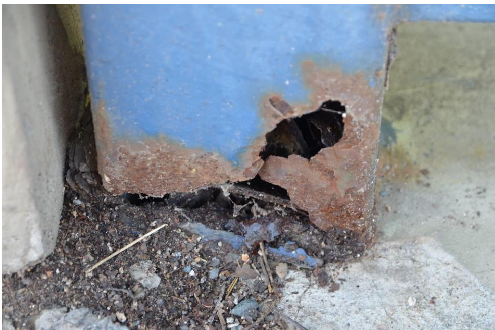
Obr.F45-206 Příklad paty sloupku levostranného zábradlí. Pohled doleva proti vodě a dolů,
