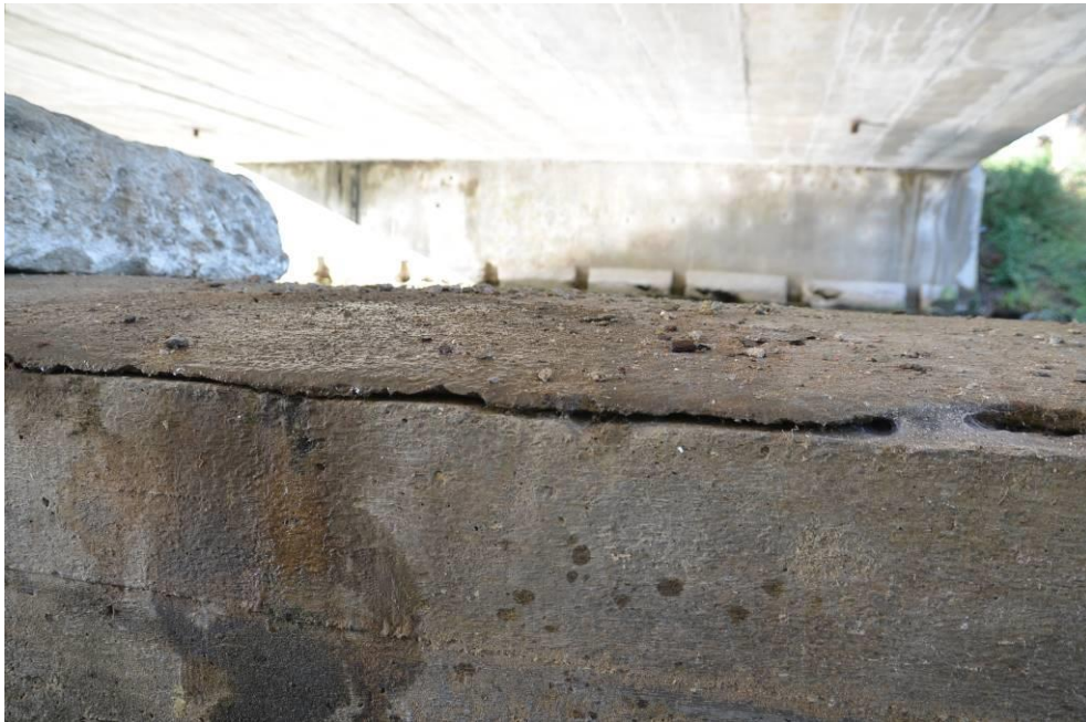
Obr.F45-55 Temeno piliřovité dolní části druhé podpěry mezi 2. a 3 sloupem. Pohled proti směru staničení,
