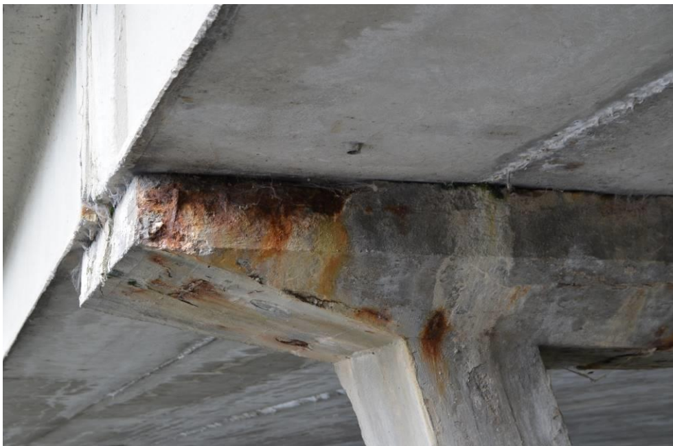
Obr.F45-25 Detail přední strany návodního (levého) konce UP druhé podpěry. Pohled ve směru staničení, po vodě a vzhůru,
