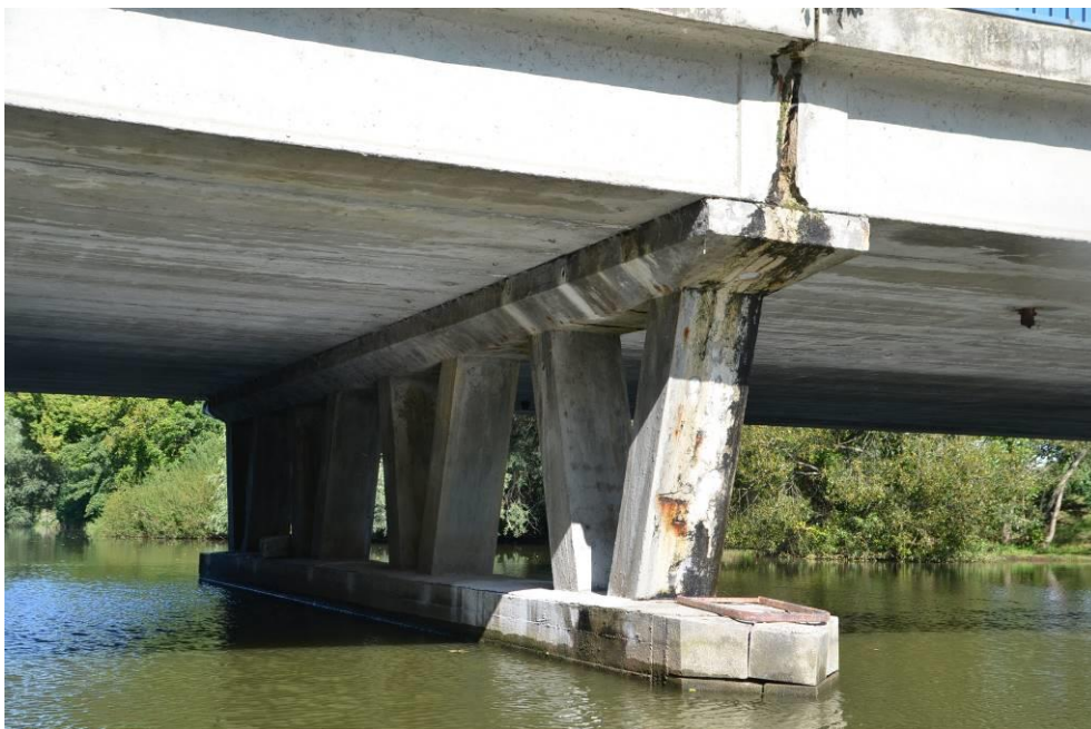
Obr.F45-144 Přední strana a čelo povodního konce druhé podpěry. Pohled proti vodě a ve směru staničení,
