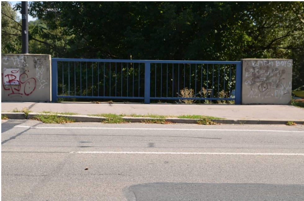
Obr.F45-195 Mostní svršek na začátku mostu. Pohled z levostranného chodníku po vodě,
