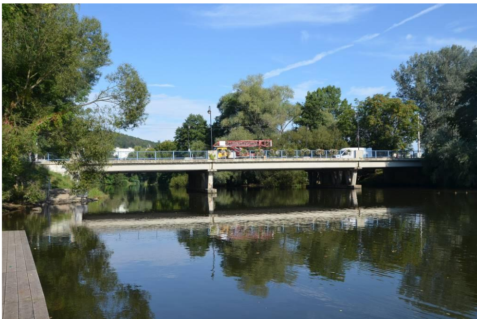
Obr.F45-06 Pravá, povodní strana mostu. Pohled z pravého břehu řeky doleva, proti vodě a ve směru staničení, k Žabovřeskám,
