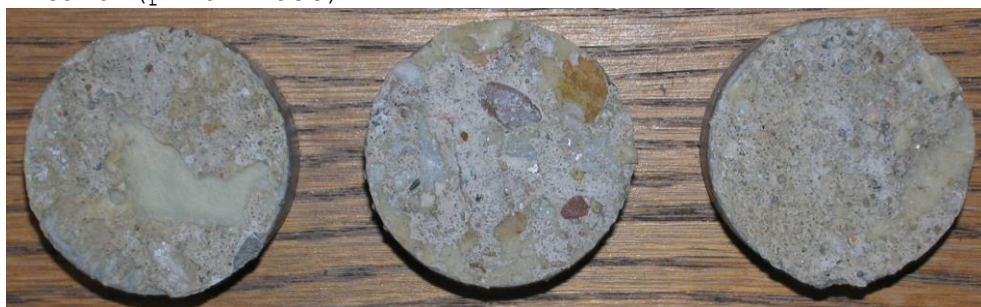
Obr.F45-601 Zkušební terče číslo 35, 43, 114 (zkušební místo 1) po provedení odtrhu.
