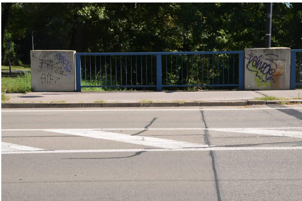
Obr.F45-197 Mostní svršek na konci mostu. Pohled z levostranného chodníku po vodě,
