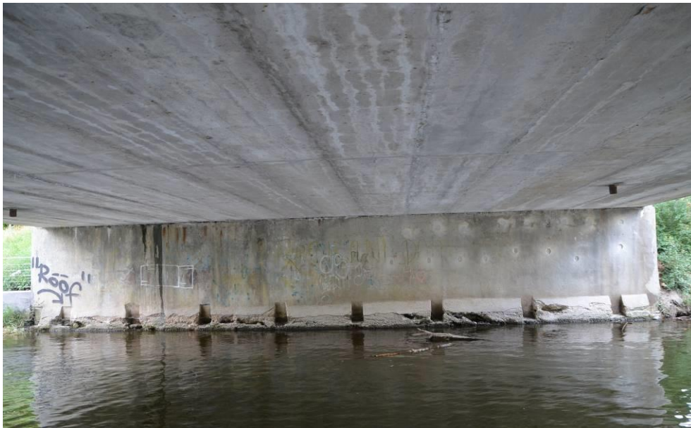
Obr.F45-31 Podpěra 1., pravobřežní, jundrovská opěra. Pohled proti směru staničení,
