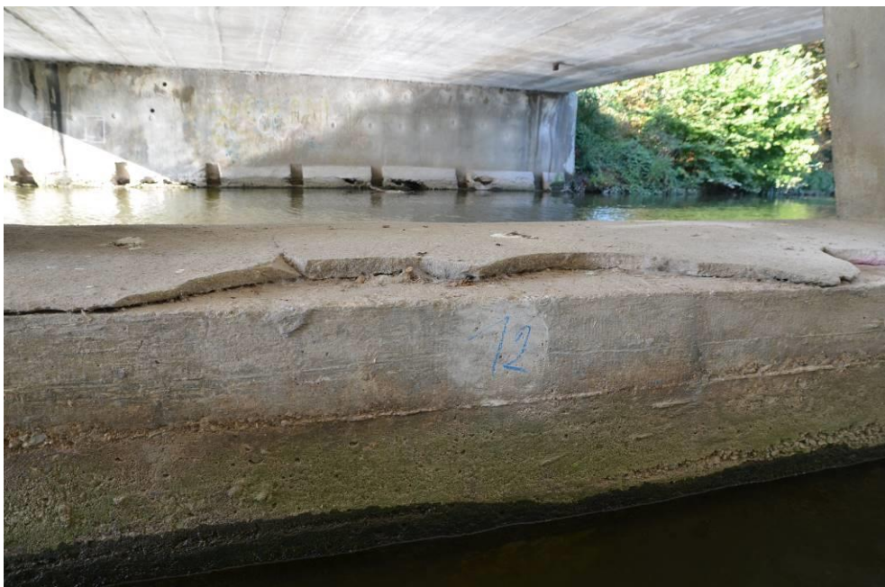
Obr.F45-62 Temeno piliřovité dolní části druhé podpěry mezi 4. a 5 sloupem. Pohled proti směru staničení,
