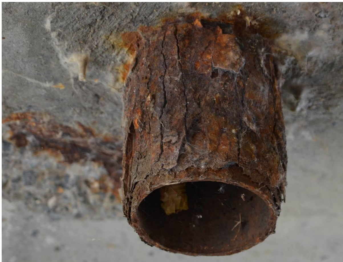
Obr.F45-19 Příklad odpadní trouby mostního odvodňovače, zde levostanného, procházejícího dutinou třetího nosníku v polovině rozpětí 1, pole. Pohled ve směru staničení a vzhůru,
