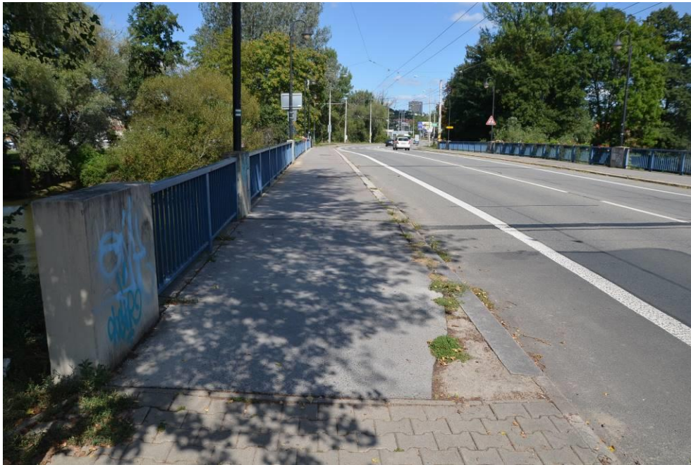
Obr.F45-190 Levý, návodní okraj mostního svršku. Pohled od 1. podpěry ve směru staničení k Žabovřeskám,
