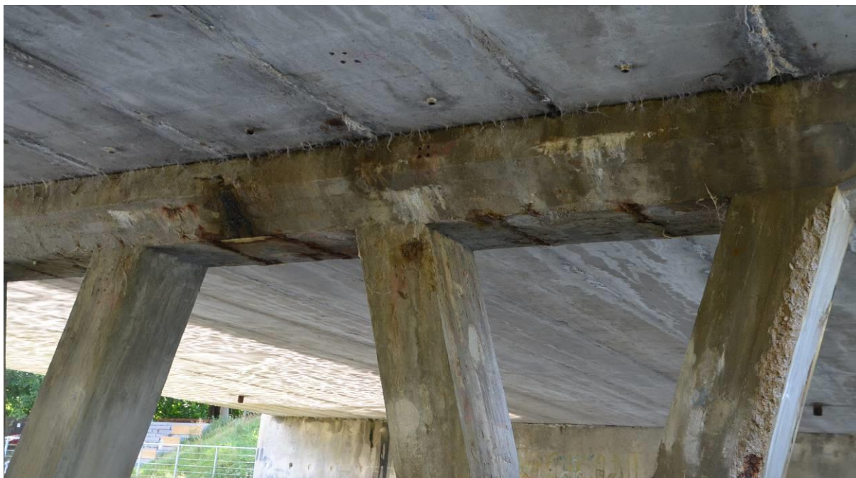
Obr.F45-142 Detail zadní strany návodního konce druhé podpěry. Pohled po vodě a proti směru (k Jundrovu),
