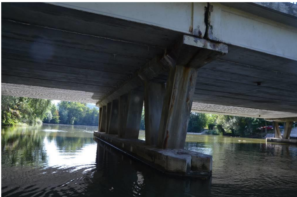
Obr.F45-155 Zadní strana a čelo návodního konce druhé podpěry. Pohled po vodě a proti směru staničení,
