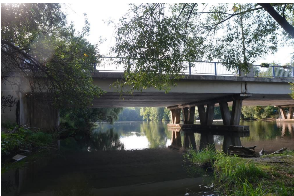
Obr.F45-04 Levá strana mostu. Pohled z levého břehu řeky diagonálně doprava, po vodě a proti směru staničení, k Jundrovu,
