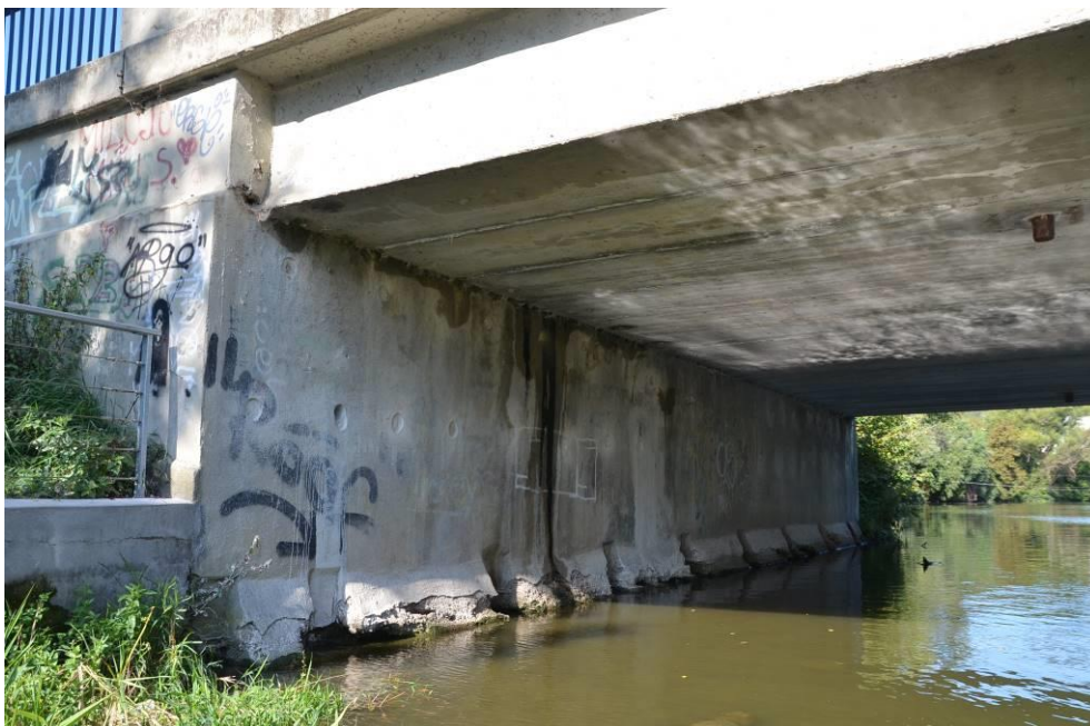
Obr.F45-125 Podpěra 1., pravobřežní, jundrovská opěra. Pohled proti směru staničení a proti vodě,
