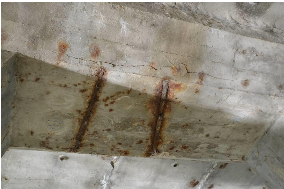
Obr.F45-100 Detail podhledu a zadní strany UP 3. podpěry mezi 6. a 7. sloupem. Pohled k Jundrovu, proti vodě a vzhůru,
