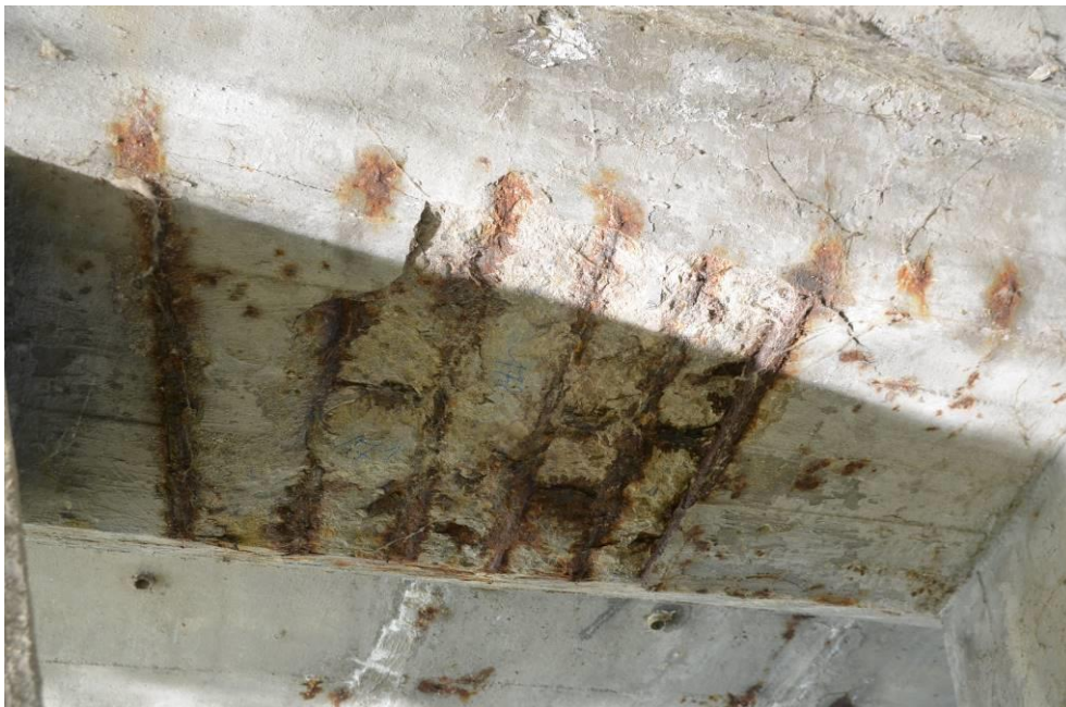
Obr.F45-95 Detail podhledu a zadní strany UP 3. podpěry mezi 5. a 6. sloupem. Pohled k Jundrovu, proti vodě a vzhůru,
