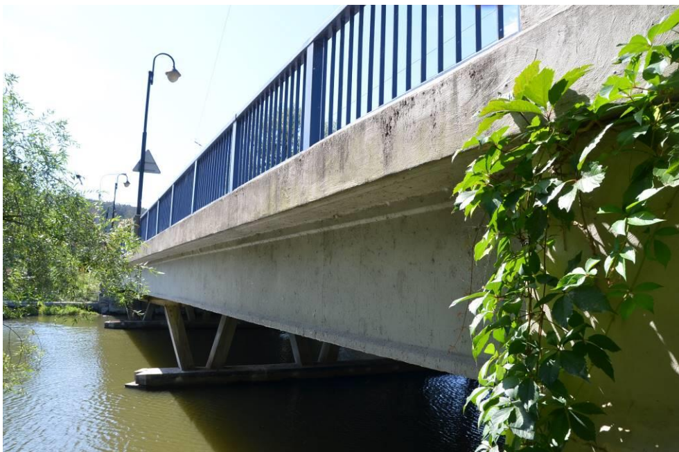
Obr.F45-168 Pravá, povodní fasáda mostu. Pohled od pravého křídla 4. podpěry proti směru staničení k Jundrovu,
