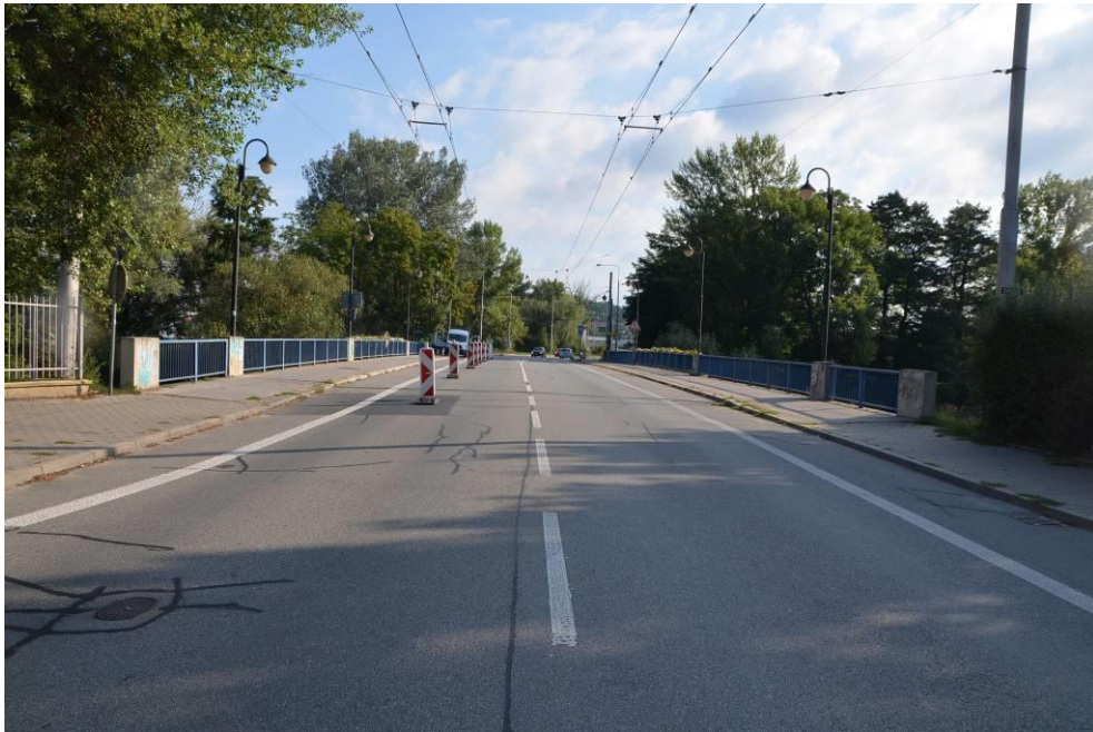
Obr.F45-01 Průhled osou mostu. Pohled ve směru staničení z pravého břehu (od Jundrova) k levému (k Žabovřeskám),
