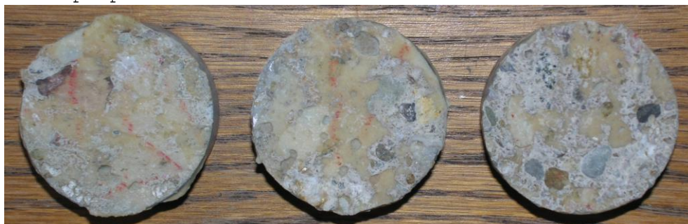
Obr.F45-606 Zkušební terče číslo 79, 82, 101 (zkušební místo 6) po provedení odtrhu.
