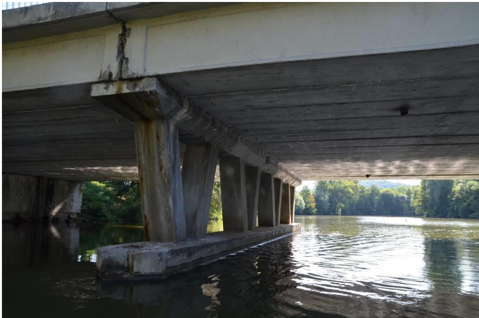
Obr.F45-148 Čelo a přední strana návodního konce třetí podpěry. Pohled ve směru staničení a po vodě,
