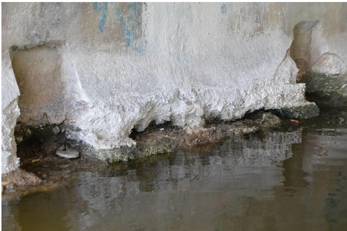
Obr.F45-130 Podpěra 1., pravobřežní, Jundrovská opěra. Pohled diagonálně proti směru staničení a proti vodě,
