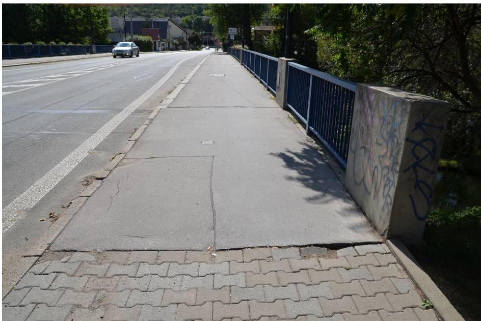
Obr.F45-192 Levý, návodní okraj mostního svršku. Pohled od 4. podpěry proti směru staničení k Jundrovu,
