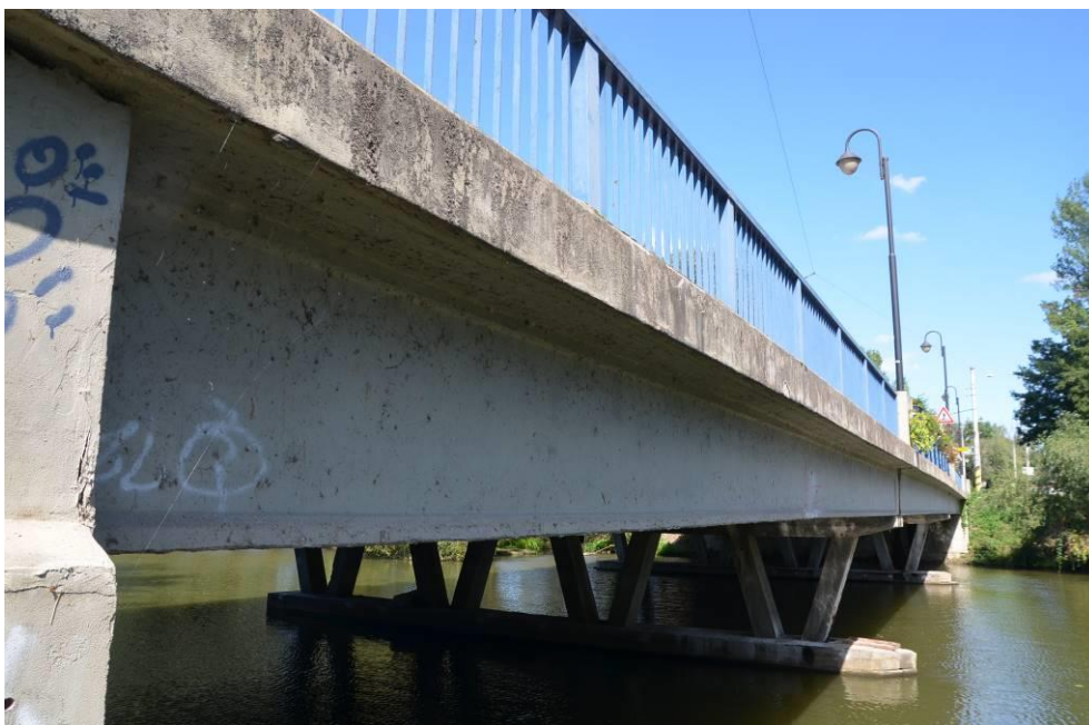
Obr.F45-163 Pravá, povodní fasáda mostu. Pohled od pravého křídla 1. podpěry ve směru staničení k Žabovřeskám,
