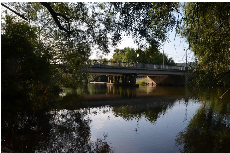
Obr.F45-03 Levá strana mostu. Pohled z levého břehu řeky diagonálně doprava, po vodě a proti směru staničení, k Jundrovu,
