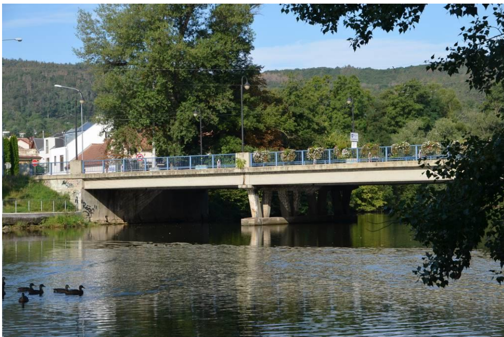
Obr.F45-05 Pravá, povodní strana mostu. Pohled z levého břehu řeky diagonálně proti směru staničení, k Jundrovu, a doleva, proti vodě,
