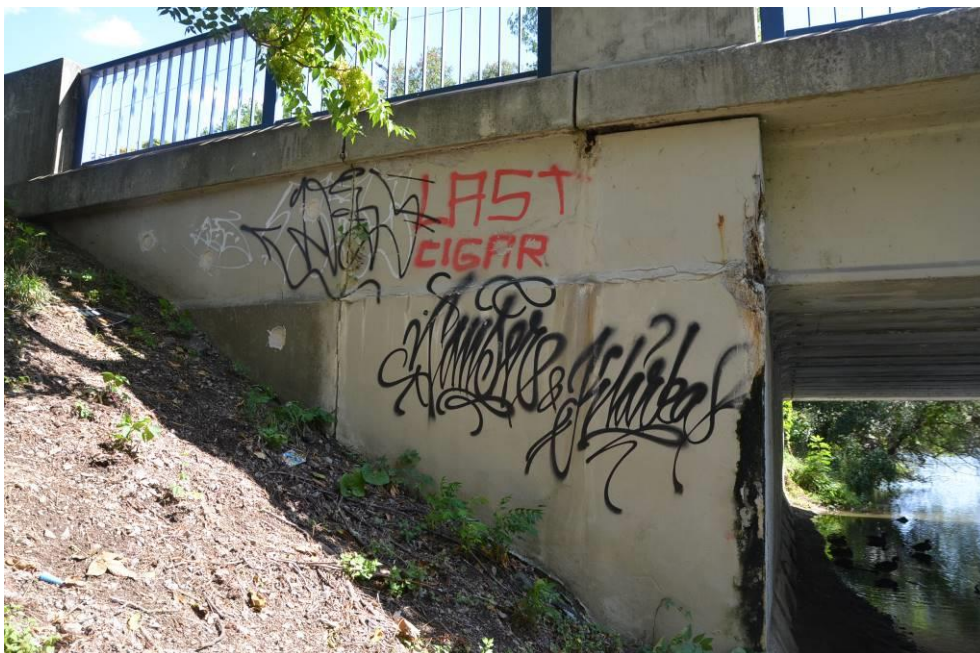
Obr.F45-167 Levé, návodní křídlo 4. podpěry, žabovřeské opěry. Pohled ve směru staničení a zleva doprava (po vodě),
