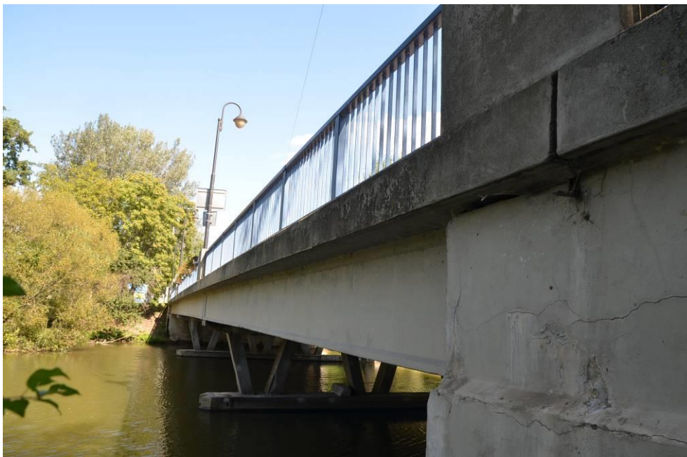
Obr.F45-161 Levá, návodní fasáda mostu. Pohled od levého křídla 1. podpěry ve směru staničení k Žabovřeskám,
