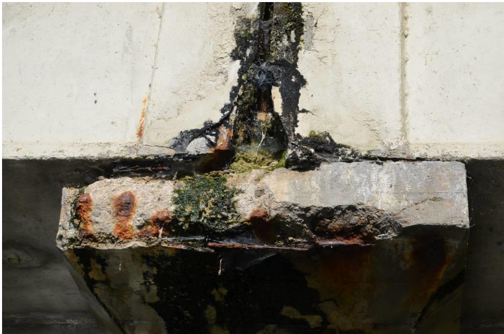
Obr.F45-116 Pravé, povodní čelo úložného prahu 3. podpěry a styk 16. nosníků 2. pole (vlevo) a 3. pole nad ním. Pohled doleva (proti vodě) a vzhůru,
