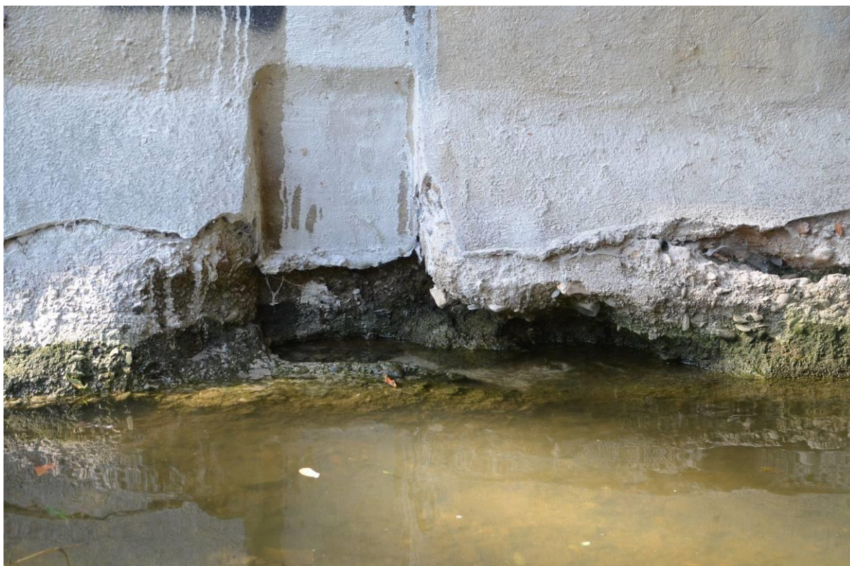
Obr.F45-132 Podpěra 1., pravobřežní, Jundrovská opěra. Pohled diagonálně proti směru staničení,
