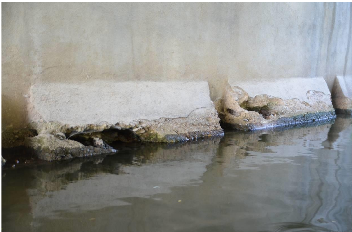
Obr.F45-128 Podpěra 1., pravobřežní, Jundrovská opěra. Pohled diagonálně proti směru staničení a proti vodě,
