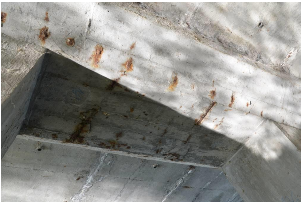
Obr.F45-91 Detail podhledu a zadní strany UP 3. podpěry mezi 4. a 5. sloupem. Pohled k Jundrovu, proti vodě a vzhůru,
