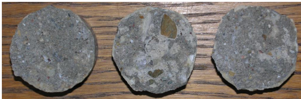
Obr.F45-613 Zkušební terče číslo 2, 90, 135 (zkušební místo 13) po provedení odtrhu.
