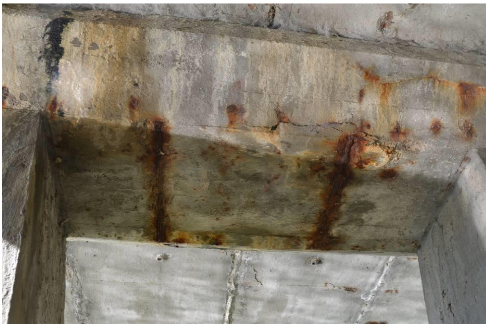
Obr.F45-101 Detail podhledu a zadní strany UP 3. podpěry mezi 7. a 8. sloupem. Pohled k Jundrovu, proti vodě a vzhůru,
