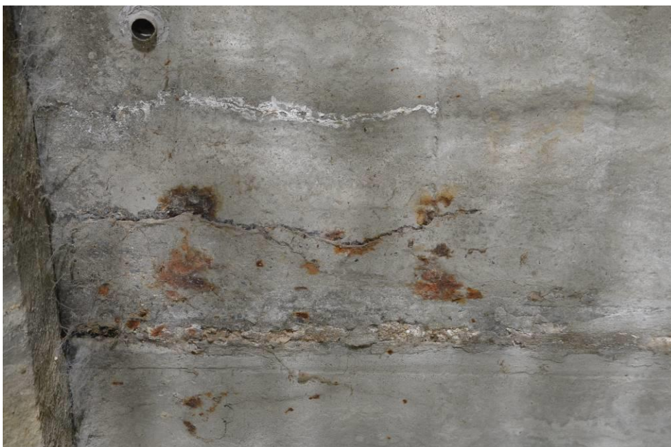
Obr.F45-109 Podhled 1. nosníku na začátku 3. pole. Pohled proti vodě a vzhůru,
