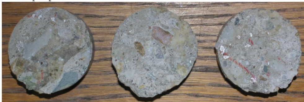
Obr.F45-602 Zkušební terče číslo 27, 60, 67 (zkušební místo 2) po provedení odtrhu.
