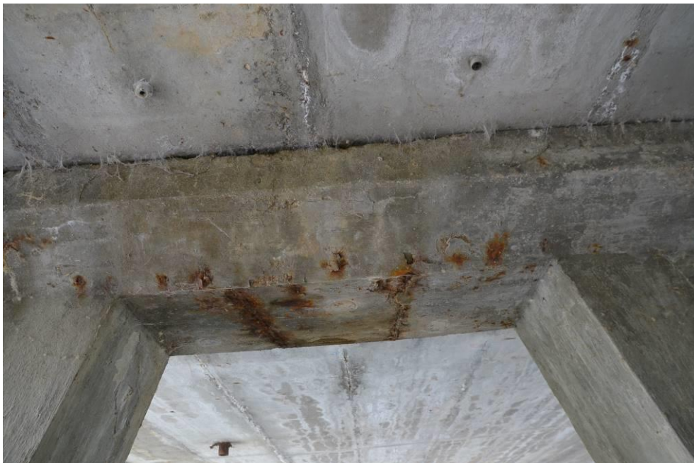
Obr.F45-28 Detail přední strany a podhledu UP druhé podpěry nad druhým až třetím sloupem. Pohled ve směru staničení a vzhůru, viz též obr. F45-142,
