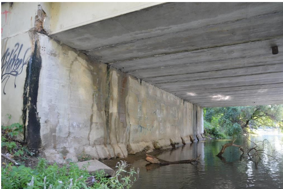
Obr.F45-118 Podpěra 4., levobřežní, žabovřeská opěra. Pohled diagonálně ve směru staničení (k Žabovřeskám) a po vodě,
