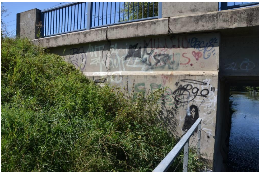
Obr.F45-164 Pravé, povodní křídlo 1. podpěry, jundrovské opěry. Pohled proti směru staničení a zprava doleva (proti vodě),
