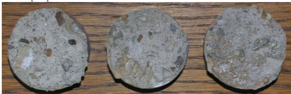
Obr.F45-607 Zkušební terče číslo 33, 42, 53 (zkušební místo 7) po provedení odtrhu.
