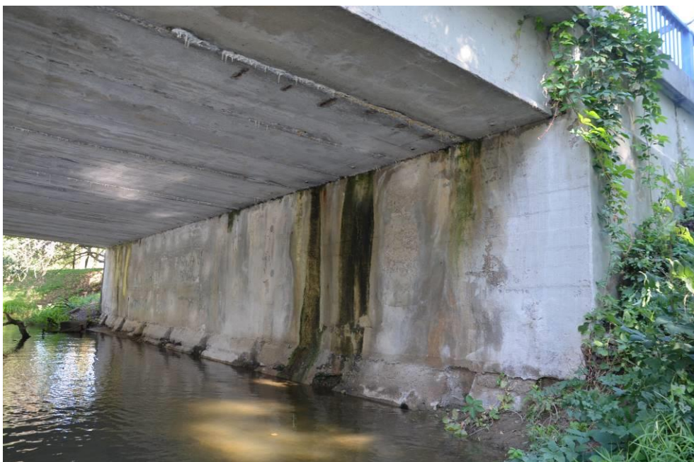
Obr.F45-120 Podpěra 4., levobřežní, žabovřeská opěra. Pohled proti vodě a ve směru staničení,
