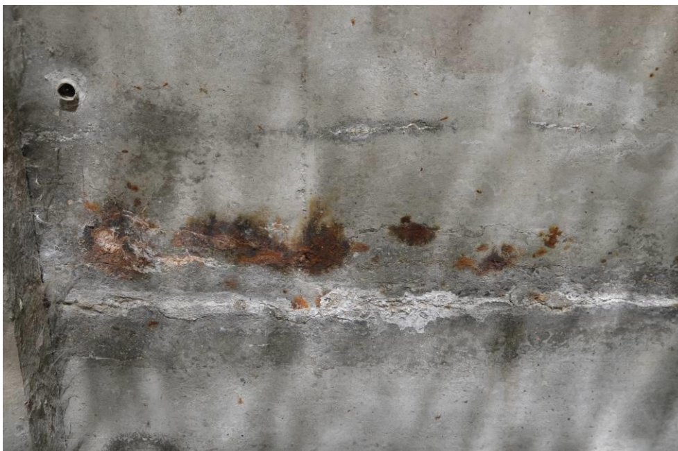
Obr.F45-105 Podhled 13. nosníku na začátku 3. pole. Pohled proti vodě a vzhůru,
