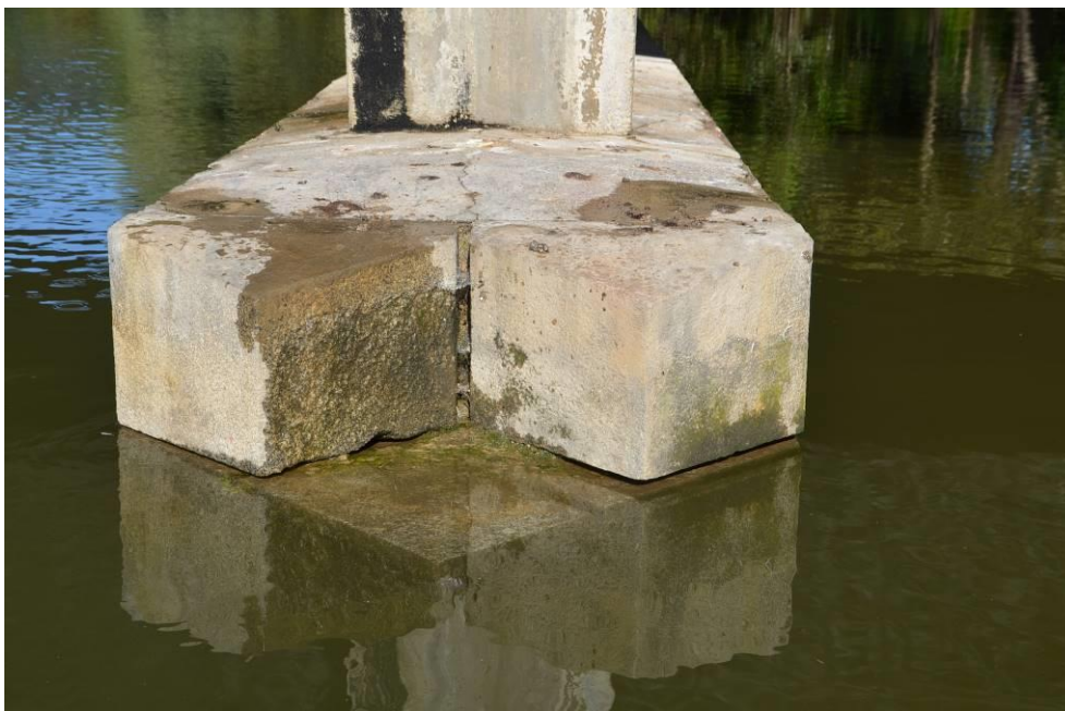
Obr.F45-114 Detail dolní části čela povodního konce 3. podpěry. Pohled proti vodě a dolů,
