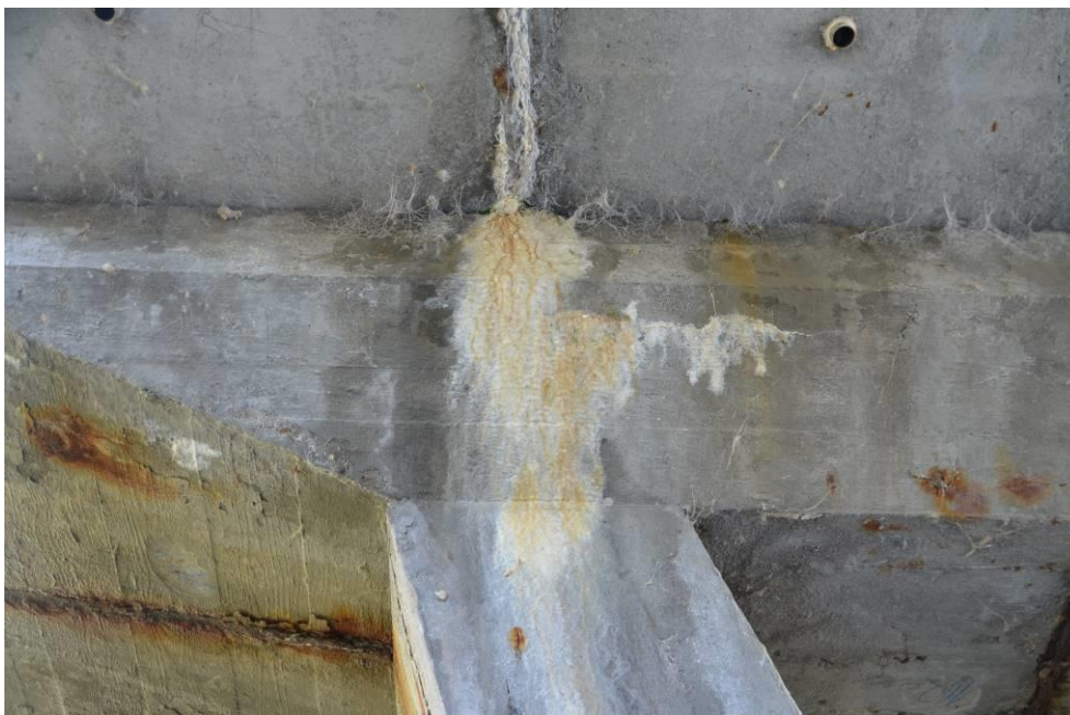
Obr.F45-150 Detail inkrustace na přední straně UP třetí podpěry pod spárou mezi 1. (vlevo) a 2. nosníkem. Pohled ve směru staničení a vzhůru,
