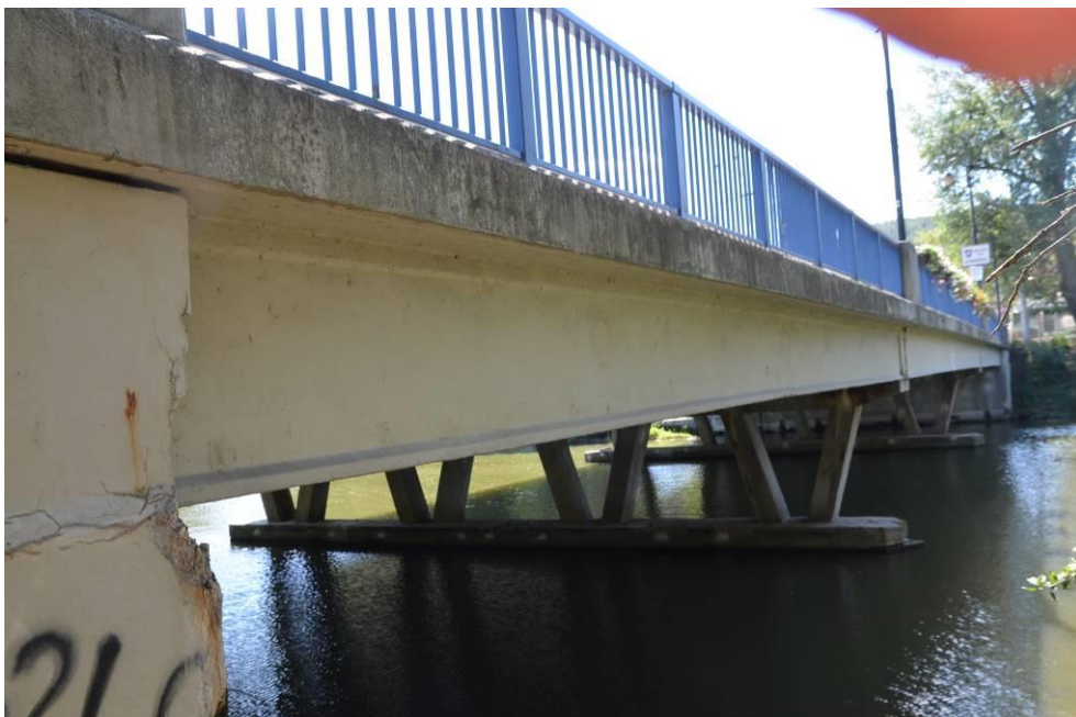
Obr.F45-166 Levá, návodní fasáda mostu. Pohled od levého křídla 4. podpěry proti směru staničení k Jundrovu,
