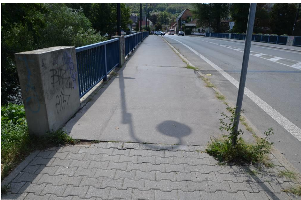
Obr.F45-193 Pravý, povodní okraj mostního svršku. Pohled od 4. podpěry proti směru staničení k Jundrovu,
