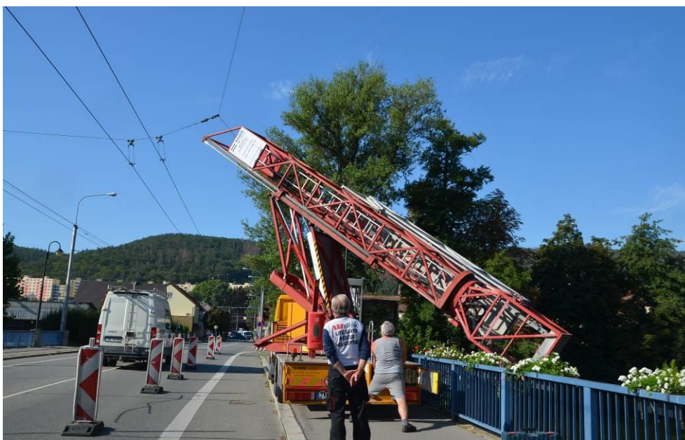
Obr.F45-08 Zpřístupnění levé návodní strany pomocí mostní prohlížečky MOOG MBI 90-1/S. Pohled proti směru staničení, k Jun-drovu,
