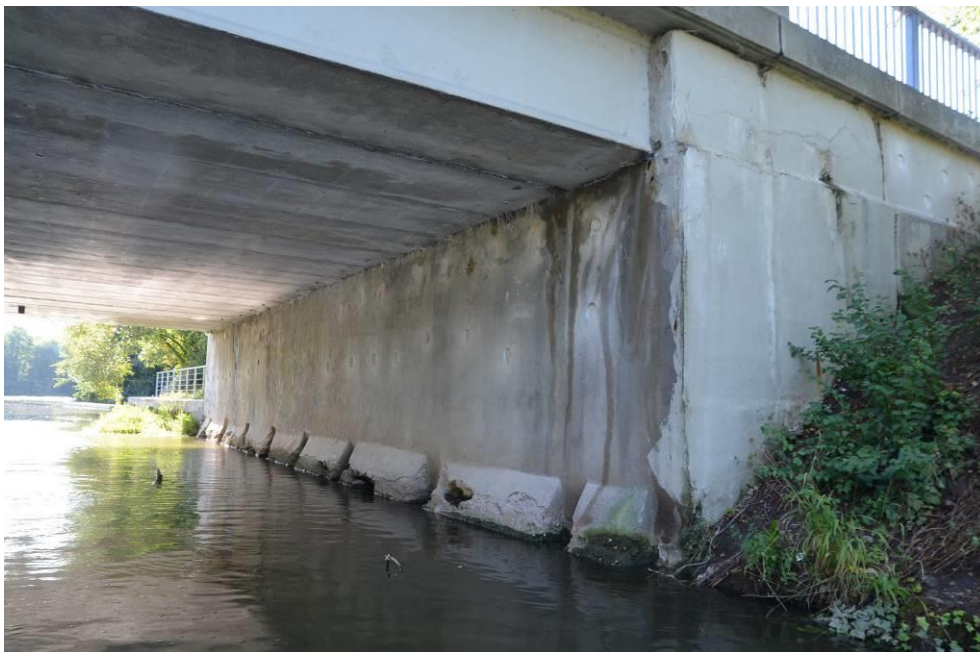
Obr.F45-123 Podpěra 1., pravobřežní, jundrovská opěra. Pohled diagonálně po vodě a proti směru staničení,
