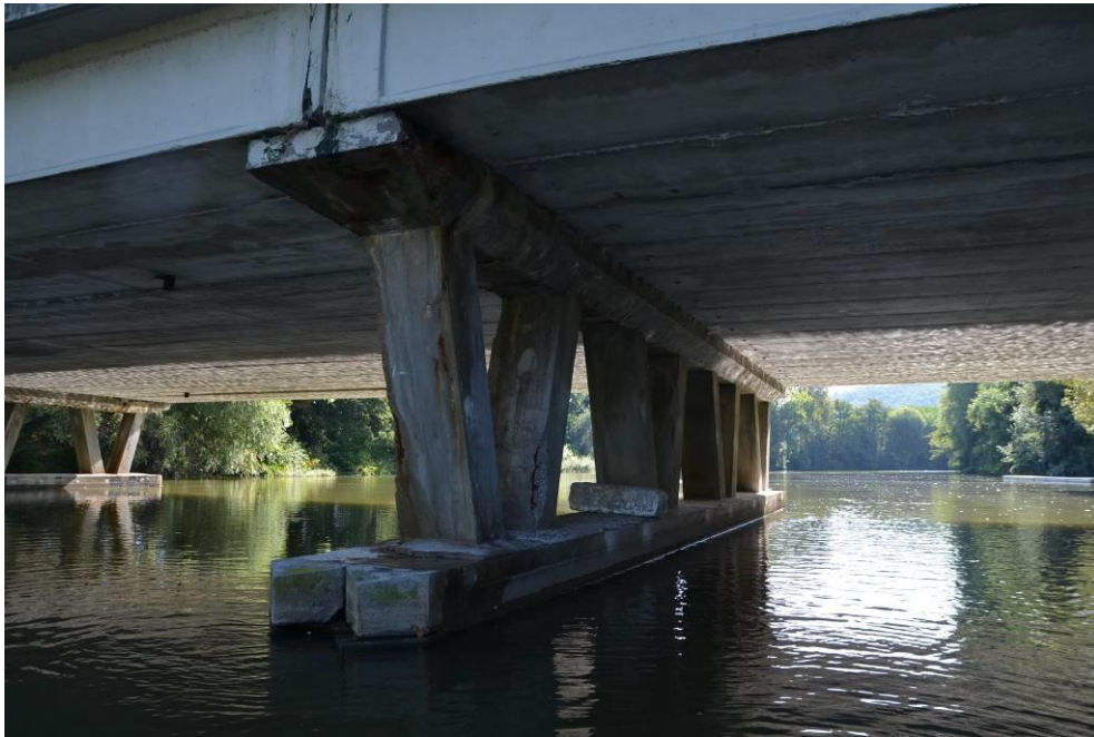
Obr.F45-138 Čelo a přední strana návodního konce druhé podpěry. Pohled ve směru staničení a po vodě,
