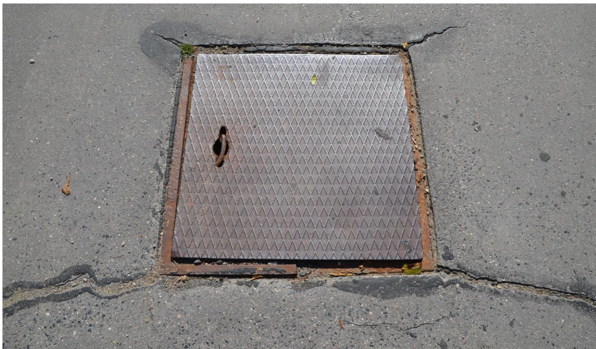
Obr.F45-203 Levostranný chodník v polovině rozpětí 3. pole Pohled zleva doprava a dolů,
