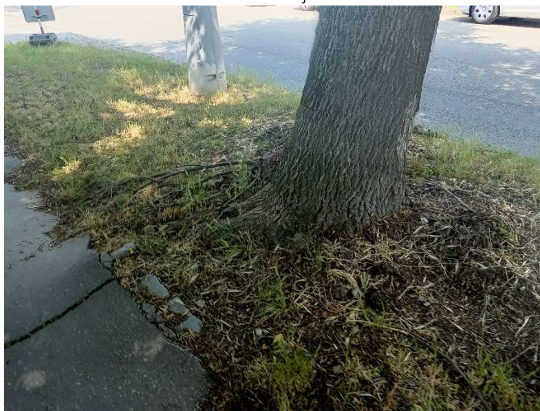
Kořenové náběhy a nadzvedání asfaltového chodníku.
