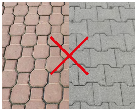
obr. 51 Betonová zámková dlažba je v jakékoliv barevné verzi nepřipustná.
