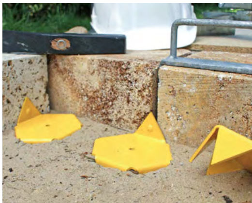
obr. 75 Kotva EAK od společnosti ISATec®.
