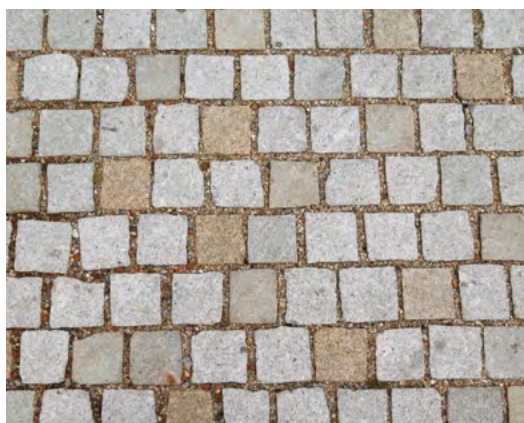
obr. 7 drobná kostka, horní a spodní strana řezaná B.2.3.c žula, 10 × 10 × 10 cm, mix barev
