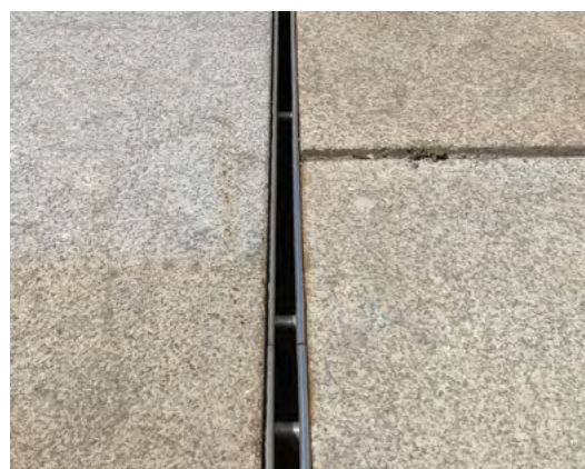
obr. 147 Doporučená podoba nerezové štěrbínové vpusti.
