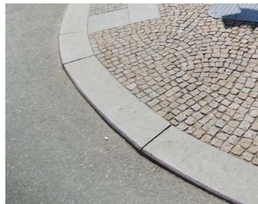
obr. 36 kamenný obrubník B.2.7.a
