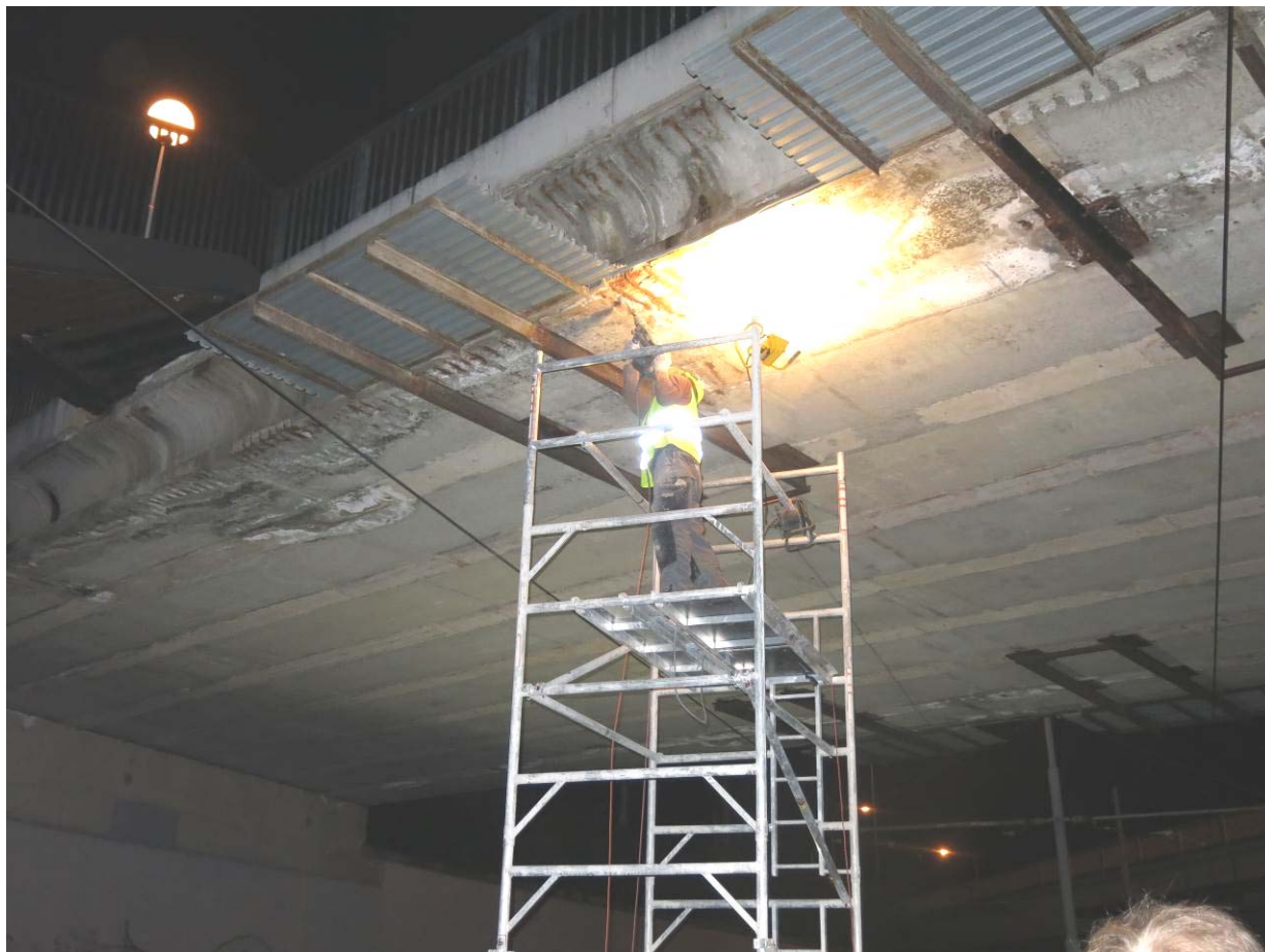
Obr. 4.18: Realizace sekané sondy pro odhalení kabelového kanálku na pravém krajním nosníku.
