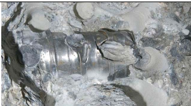
Obr. 4.32: Odhalení předpínacího kabelu K7-2.
