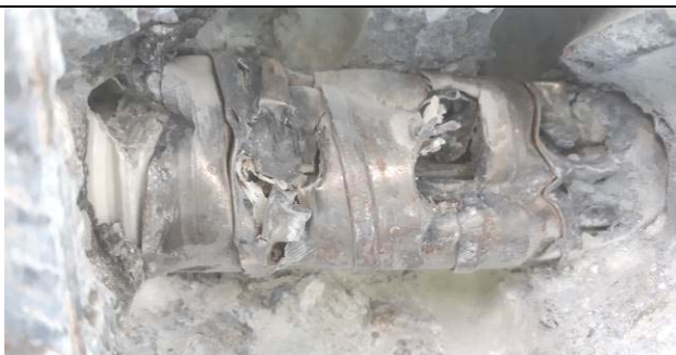
Obr. 4.22: Odhalení předpínacího kabelu K1-6.
