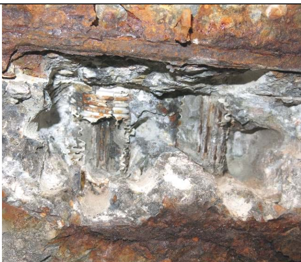
Obr. 4.30: Odhalení předpínacích kabelů K5-9 a K5-10.
