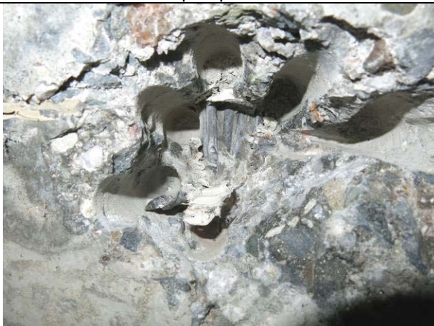
Obr. 4.28: Odhalení předpínacího kabelu K4-10.
