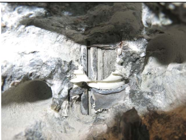
Obr. 4.29: Odhalení předpínacího kabelu K5-1.
