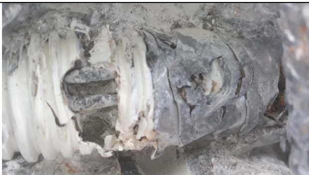
Obr. 4.23: Odhalení předpínacího kabelu K2-6.
