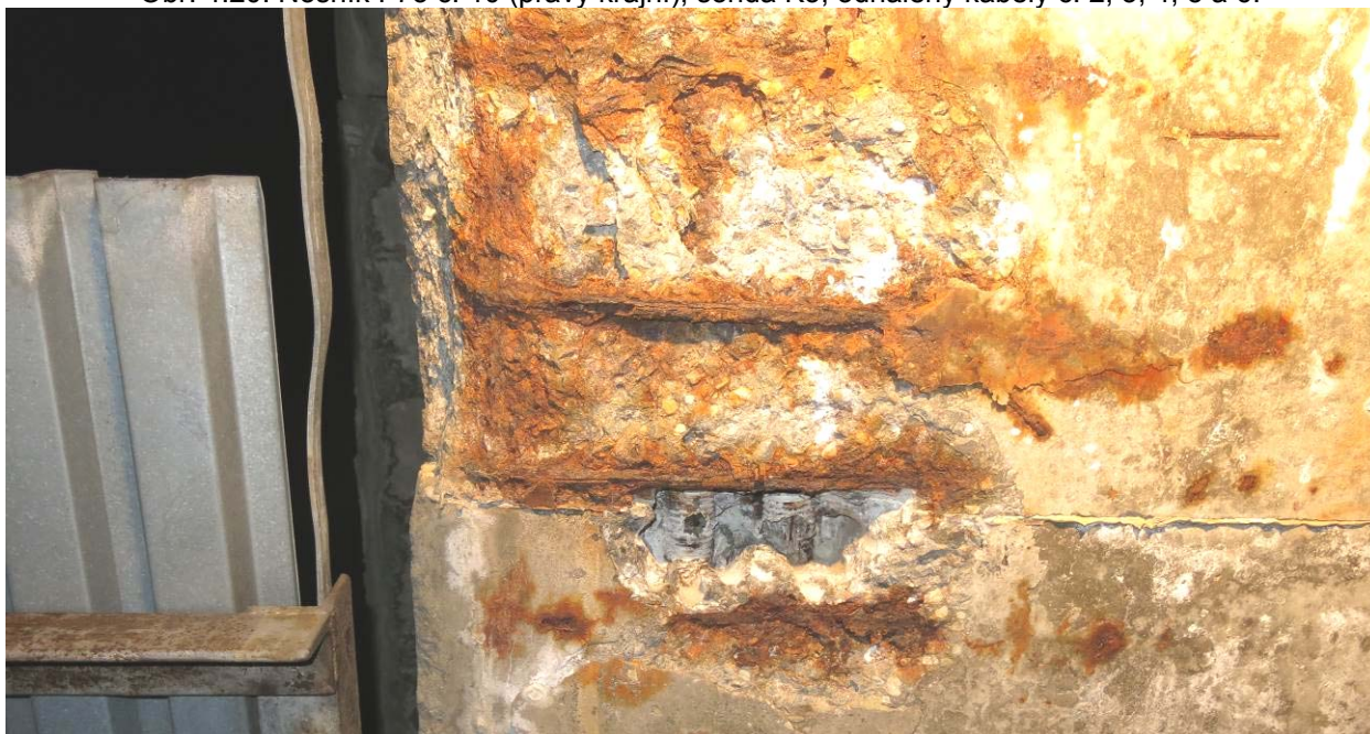
Obr. 4.21: Nosník I-73 č. 10 (pravý krajní), sonda K5 v místě výrazného zatékání a degradace betonu, odhaleny kabely č. 10, 9 a 1.
