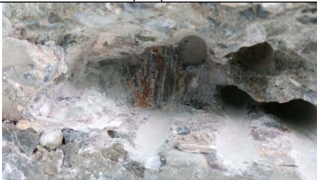
Obr. 4.24: Odhalení předpínacího kabelu K3-2.
