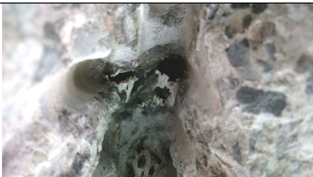
Obr. 4.26: Odhalení předpínacího kabelu K3-5.
