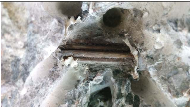
Obr. 4.25: Odhalení předpínacího kabelu K3-4.
