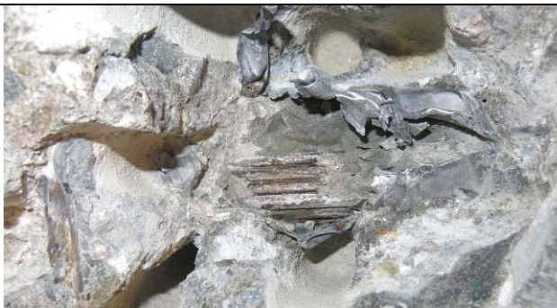
Obr. 4.31: Odhalení předpínacího kabelu K6-10.
