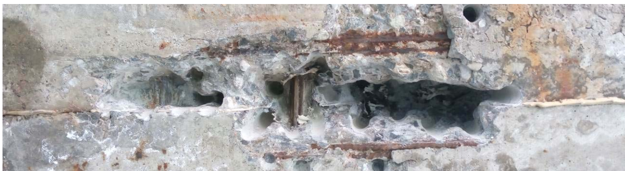
Obr. 4.20: Nosník I-73 č. 10 (pravý krajní), sonda K3, odhaleny kabely č. 2, 3, 4, 5 a 6.
